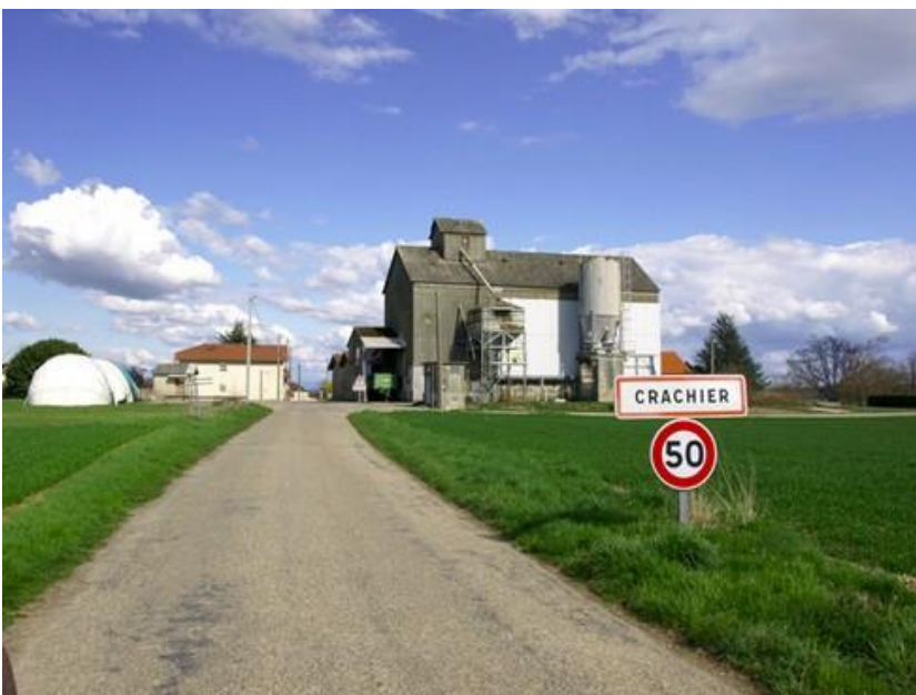
Bâtiment agricole dans le village de Crachier (Nord-Isère).
